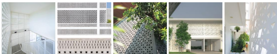
ภาพที่ 3 อิฐช่องลมงานฝีมือในสถาปัตยกรรมเปลือกอาคารร่วมสมัย
