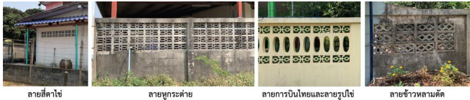
ภาพที่ 2 การใช้งานบล็อกคอนกรีตเป็นช่องลมห้องน้ำและรั้วบ้าน
