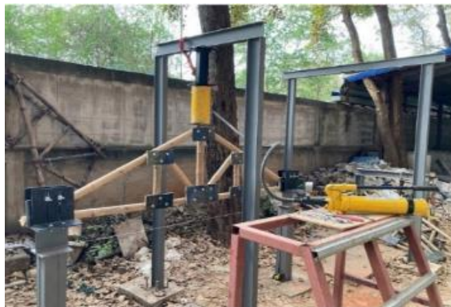
ภาพที่ 3 การติดตั้งชุดทดสอบกำลังรับแรงโครงข้อหมุน
