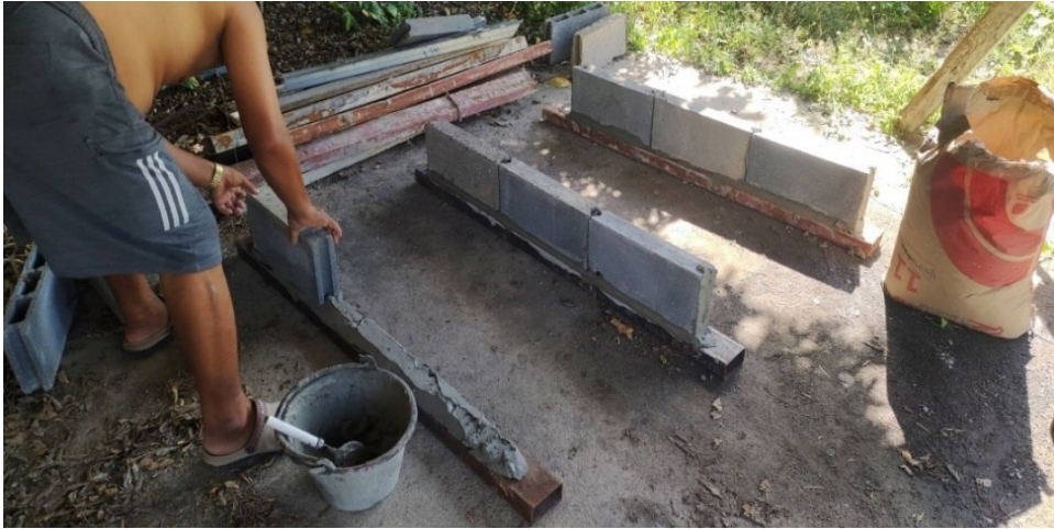
ภาพที่ 2 แสดงขั้นตอนการก่อผนังเตรียมการฉาบและจับเซียม
