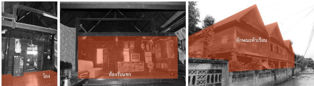
ภาพที่ 5 แสดงภาพโถงกลาง พื้นที่รับแขก และมุมมองภายนอกอาคารของเรือนนางสมพร
