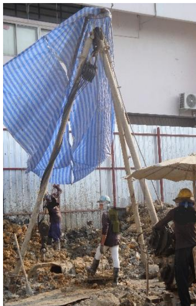
ภาพที่ 1 การทำเสาเข็มเจาะระบบแห้ง
