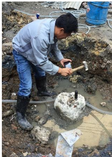
ภาพที่ 2 การตรวจสอบความสมบูรณ์ของเสาเข็มด้วยวิธี Seismic Integrity Test
