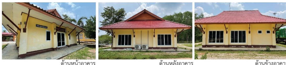
ภาพที่ 5 ลักษณะทางกายภาพโรงเรียนผู้สูงอายุ
