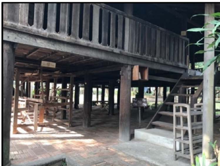
ภาพที่ 2 บ้านเลื่อนระบายอากาศของเรือนฝาลือ ที่มา: พิพิธภัณฑ์เรือนโบราณล้านนา จังหวัดเชียงใหม่ 2564
