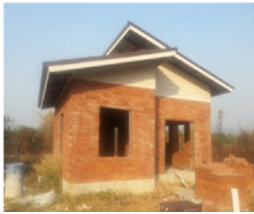
(ค) การมุงหลังคาบ้านอิฐประสาน
