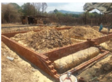
(ง) ก่ออิฐประสานจากฐานรากที่เทแล้วเสร็จ
