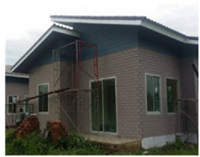
(ง) บ้านอิฐประสานหลังก่อสร้าง แล้วเสร็จ
