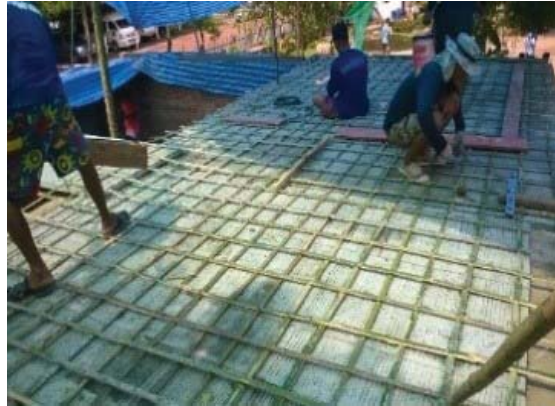
ภาพที่ 6 ขั้นตอนการก่อสร้าง
