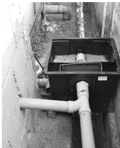
ภาพที่ 11 คู่มือการทำถังดักไขมันและถังดักไขมันที่ติดตั้งไว้
