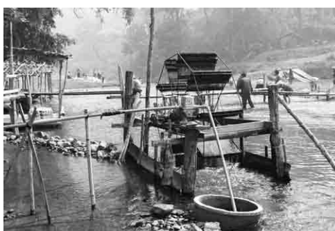
ภาพที่ 7 การนำน้ำมาใช้โดยใช้กังหันวิดน้ำ
