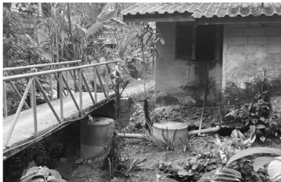
ภาพที่ 6: บ้านอาสาสมัครหลังปรับบ่อเกรอะบ่อซึมและท่อระบายน้ำ
