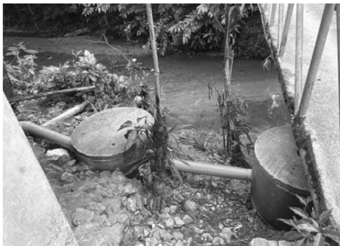
ภาพที่ 6: บ้านอาสาสมัครหลังปรับบ่อเกรอะบ่อซึมและท่อระบายน้ำ
