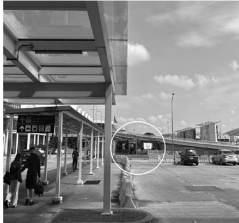
ภาพที่ 8: สนามบินภูเก็ต (มุมมองจากอาคาร) พื้นที่สูบบุหรี่ระหว่างอาคารผู้โดยสารระหว่างประเทศ และภายในประเทศ อยู่ห่างจากอาคารประมาณ 200 เมตร (24 มกราคม 2568)
