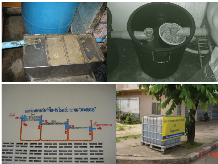
ภาพที่ 2 ถังดักไขมันในบ้านค้า บ้านเรือน โรงเรียนและถังใส่น้ำหมักจุลินทรีย์ (EM) บริเวณท่อระบายน้ำ
