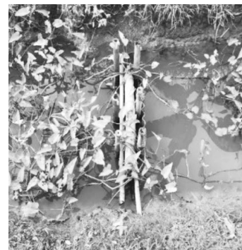
ภาพที่ 5: คลองไส้ไก่และการทำฟายชะลอน้ำในคลองขนาดกลางของศูนย์การเรียนรู้
