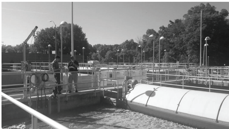
ภาพที่ 6 โรงบำบัดน้ำเสีย Beam Road เมือง Brecknock Township เมือง Lancaster County รัฐเพนซิลวาเนีย
