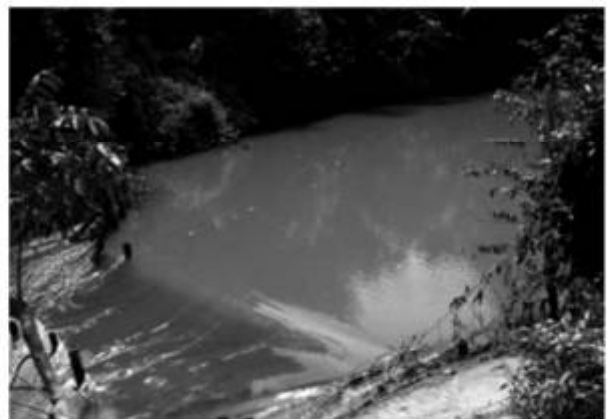
ภาพที่ 7 ฝายกั้นถาวรที่มีหูก้างที่แข็งแรงมั่นคงและมีพันธุ์ไม้ริมคลอง จะช่วยให้ฝายมั่นคงใช้งานได้นาน
