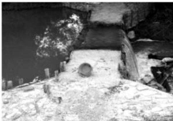
ภาพที่ 7 ฝายกั้นถาวรที่มีหูช้างที่แข็งแรงมั่นคงและมีพันธุ์ไม้ริมคลอง จะช่วยให้ฝายมั่นคงใช้งานได้นาน
