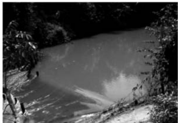
ภาพที่ 7 ฝายกั้นถาวรที่มีหูช้างที่แข็งแรงมั่นคงและมีพันธุ์ไม้ริมคลอง จะช่วยให้ฝายมั่นคงใช้งานได้นาน
